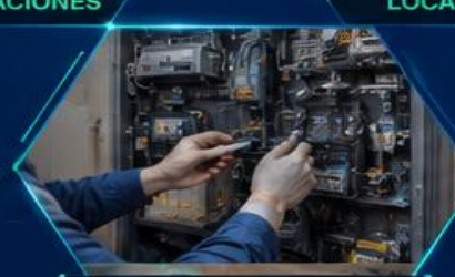
MANTENIMIENTO PREVENTIVO Y CORRECTIVO
