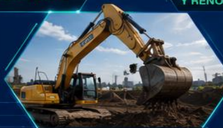
EXCAVACIONES Y MOVIMIENTOS DE TIERRA
